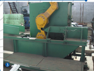
① 轧机检修中 mill maintenance
